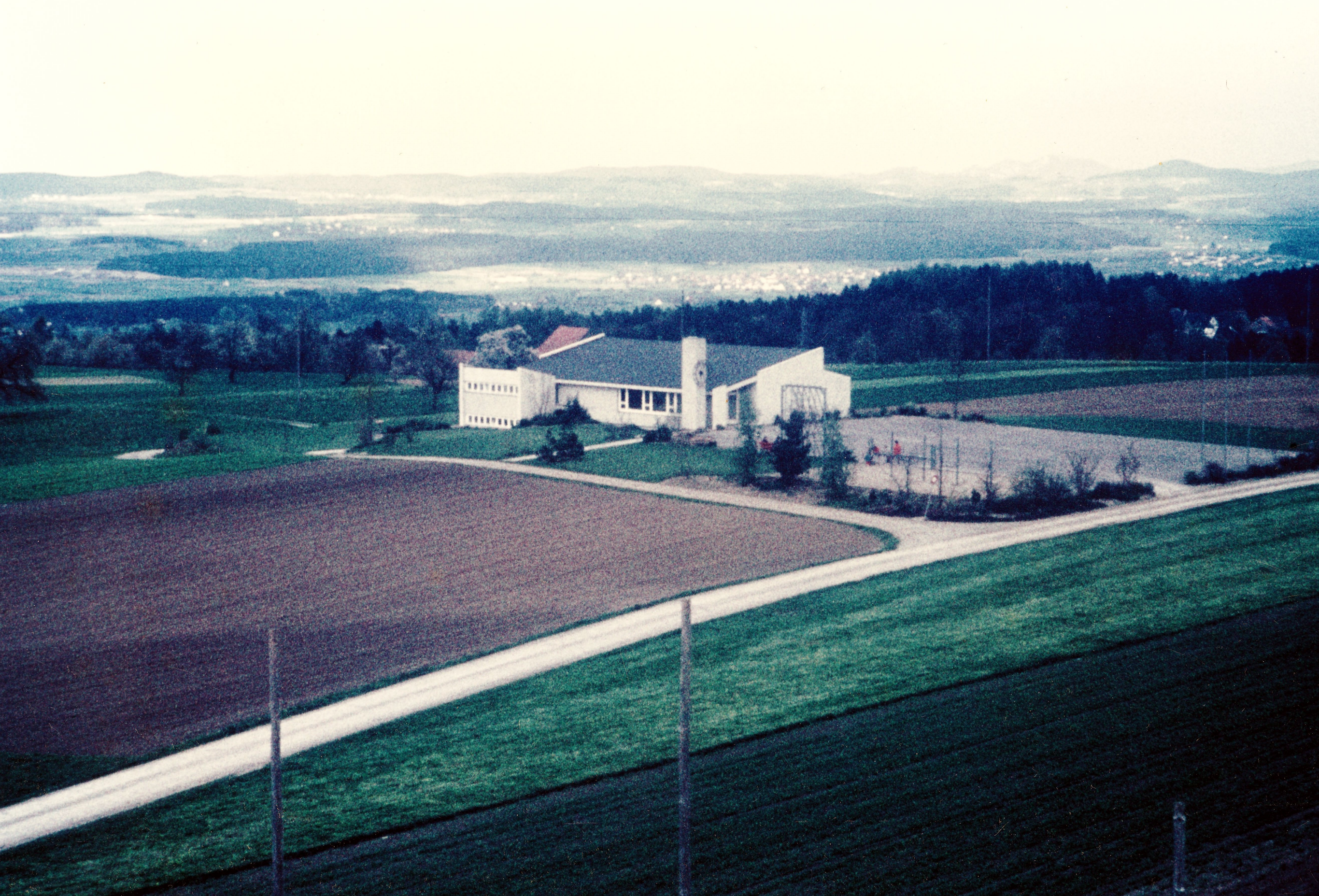
1960/1961 - Schulhaus Bommern, Pfaffhausen
