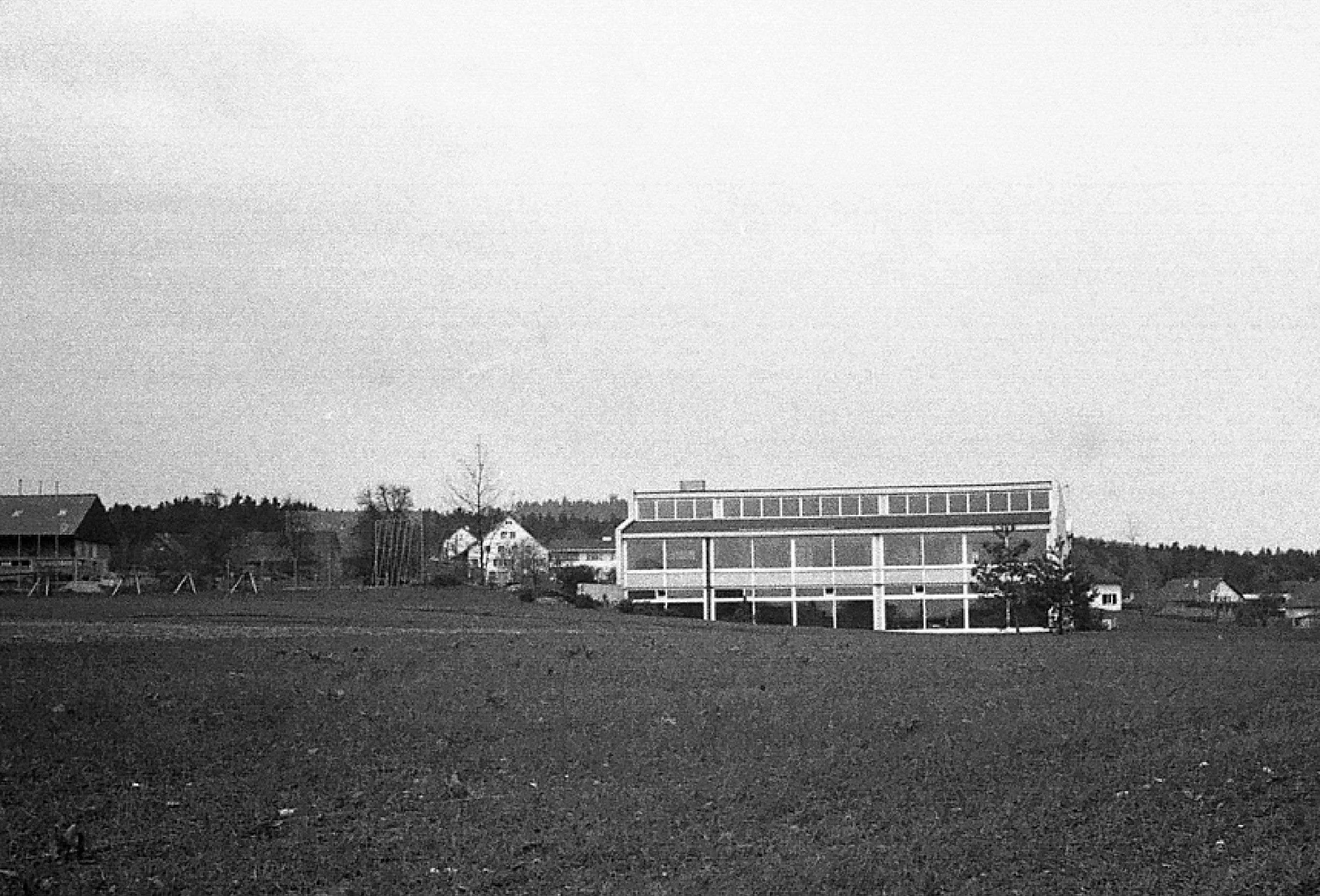
1960/1961 - Schulhaus Bommern, Pfaffhausen
