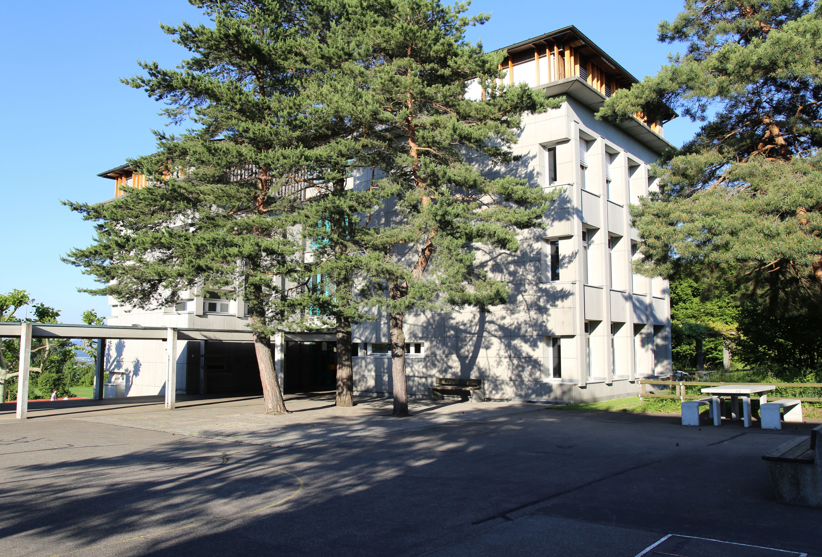
1971 - Schulhaus Bommern, Pfaffhausen
