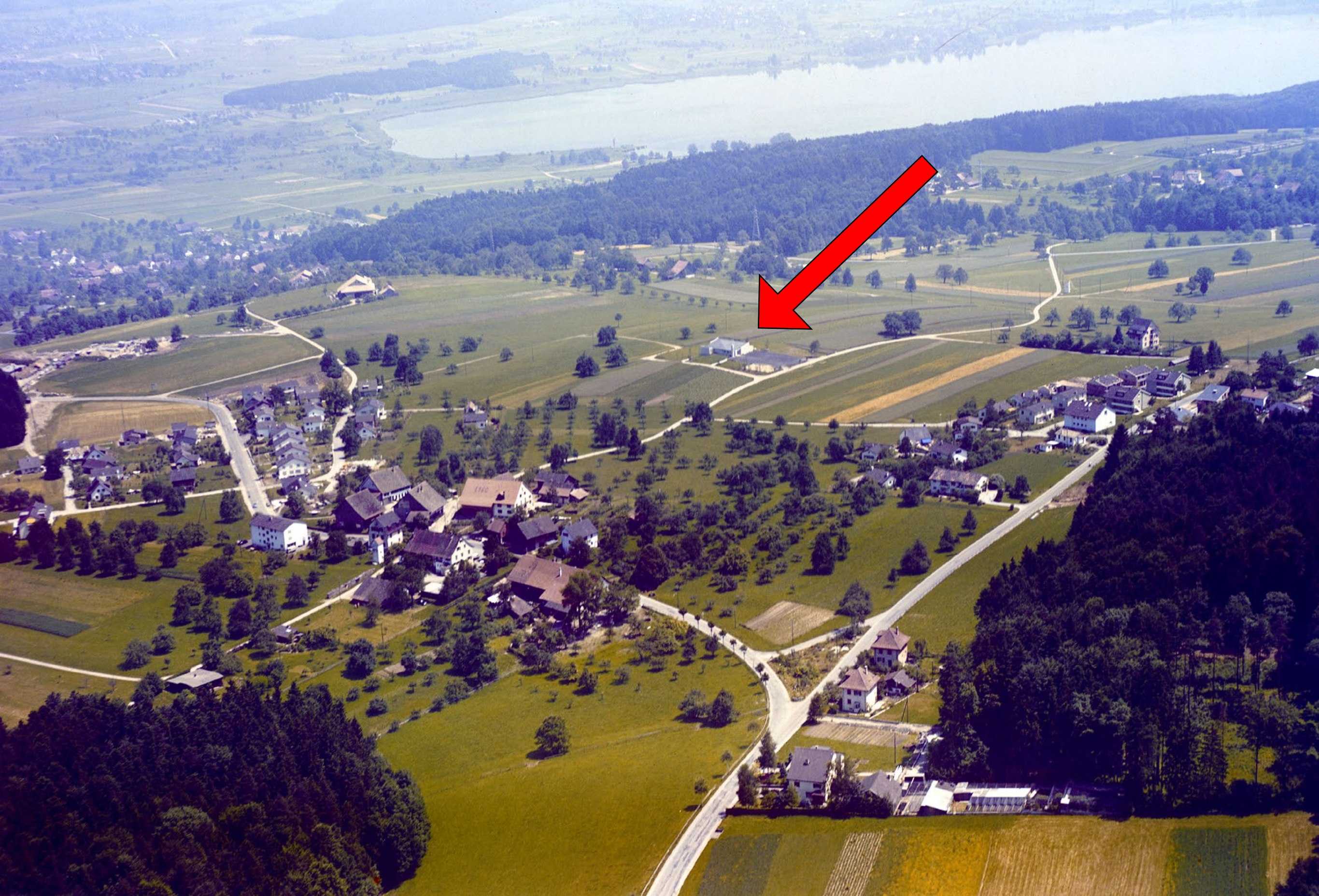
1960/1961 - Schulhaus Bommern, Pfaffhausen
