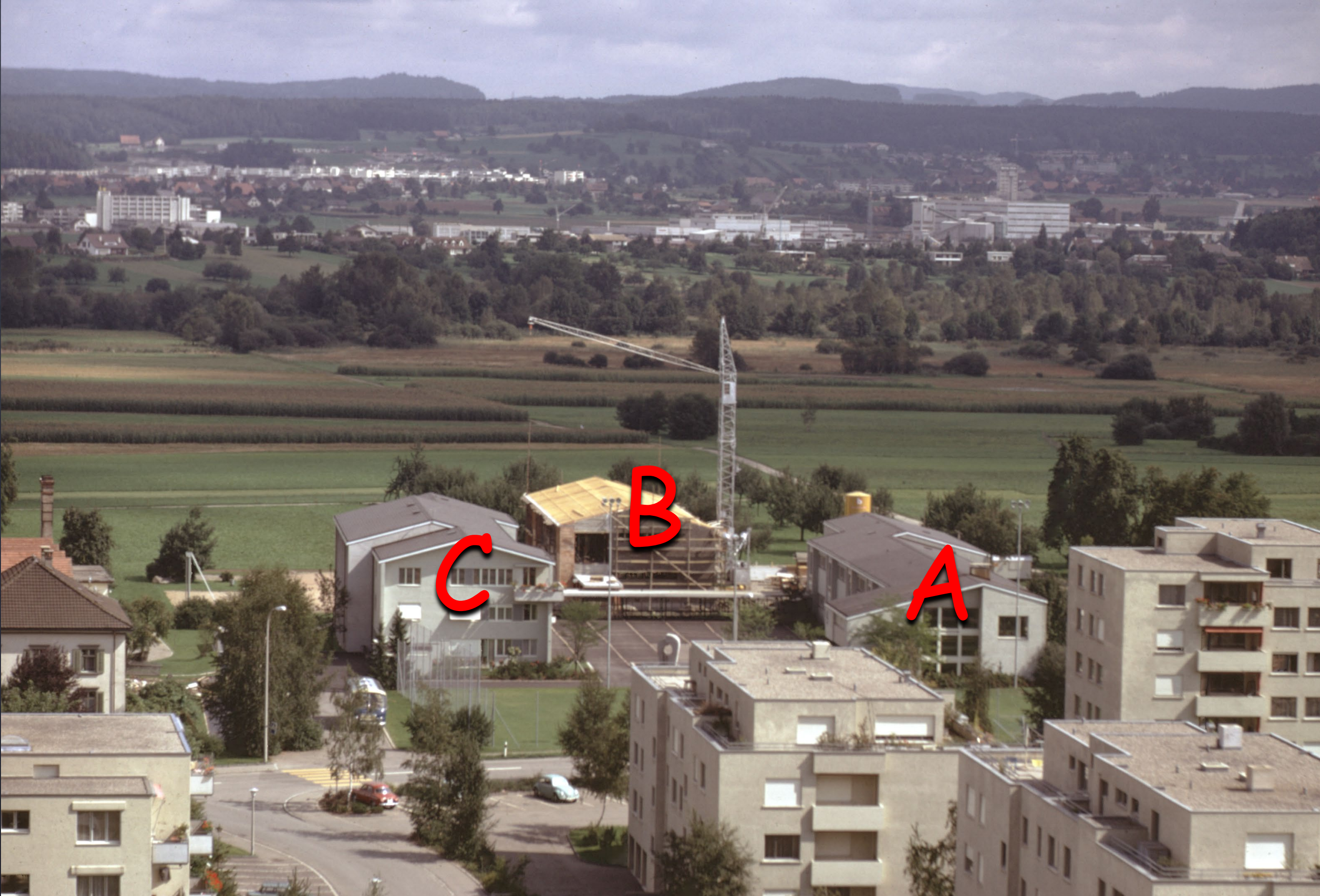
1971 - Schulhaus Lätten C, Fällanden
